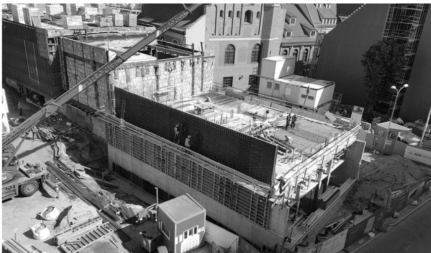
Nākotnes Nama celtniecības darbi. 2019. gada 30. maijs // The construction site, 30 May 2019
