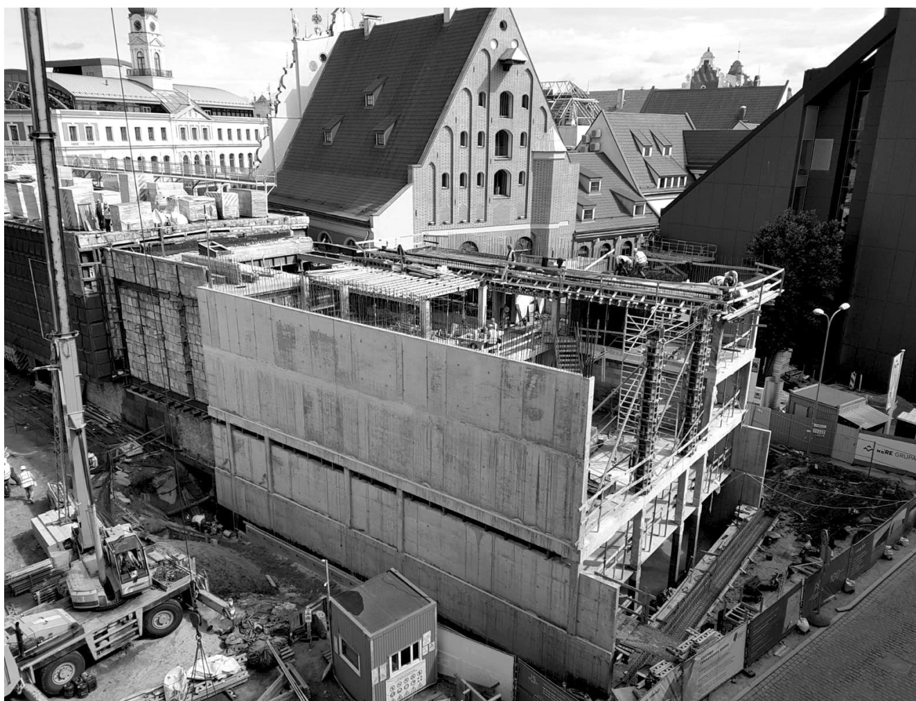
Nākotnes Nama celtniecības darbi. 2019. gada 11. jūlijs // The construction site, 11 July 2019
