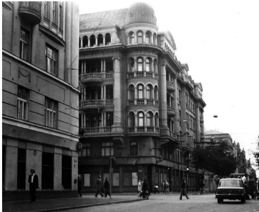
Latvijas PSR Valsts Drošības komitejas (VDK) galvenā ēka Rīgā, Brīvības un Stabu ielas krustojumā.
