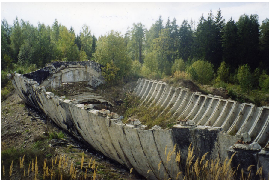
Krievijas armijas ieroču noliktavas dzelzbetona karkass. Bārta, 1990. gadu pirmā puse.
