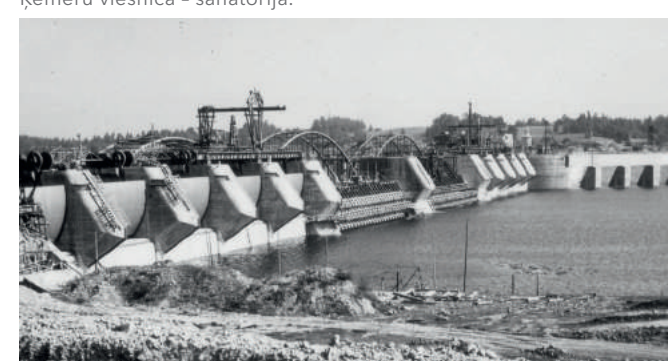
Ķeguma Valsts elektrostacijas būvniecība.
